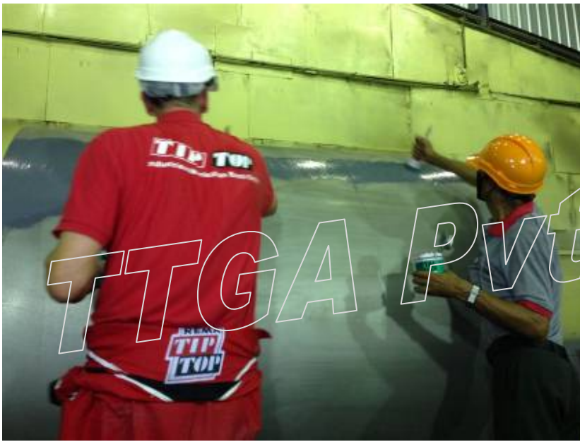
Application of Primer PR 200
